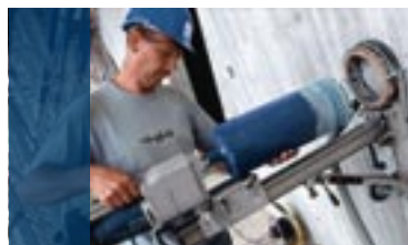
Dijamantska bušilica GDB 2500 WE Professional buši snažno i bez vibracija kroz beton sa gvozdnom armaturom.
